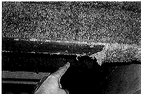
写真の状況:吹き放し工法であり、セメントスラリーもなく脱落箇所がある。
