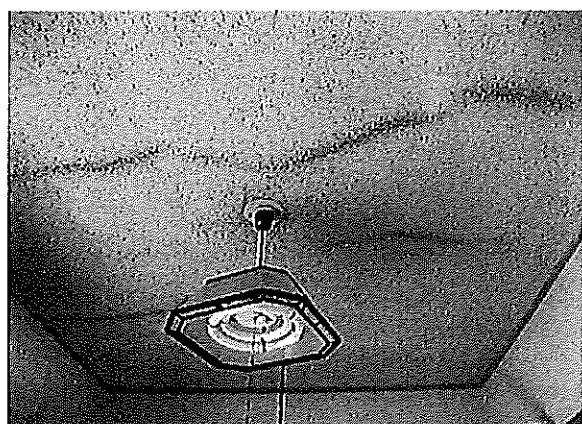
写真の状況:面的な状況はよいが、振動、乾燥、収縮などによる筋状の呼吸作用の痕が見られる。
