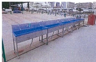
現場の手洗い場所の増設
