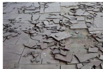
石綿が含まれている成形板等の除去工事は、原則として切断、破碎等によらない方法で行うこと。【令和3年4月～】
