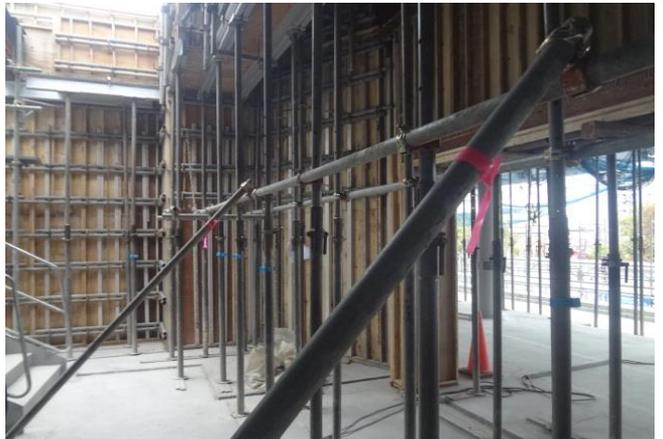
③型枠支保工の斜めサポート上部の激突注意喚起
