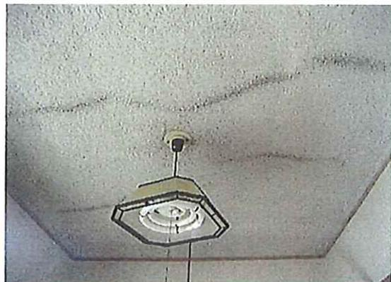
写真の状況:面的な状況はよいが、振動などによる筋状の呼吸作用の痕が見られる。
