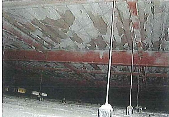
写真の状況:折板屋根において、気温や風圧による折板屋根の収縮や振動での脱落が見られる。
