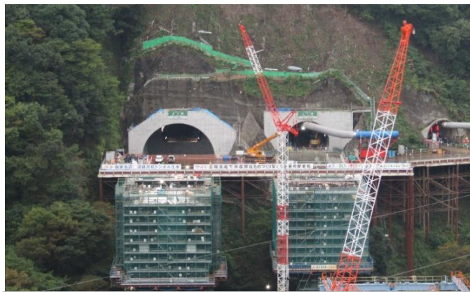
現場全景（右が上り線で左が下り線の坑口）
