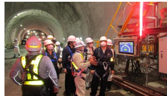
下り線坑内覆工作業場
