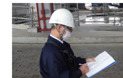
躯体内部での高所作業及び足場の確認を行う 厚木署署長
