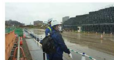
作業通路及び土止めの確認を行う 相模原署署長
