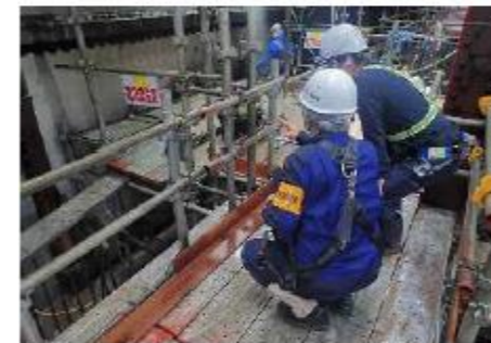
手すり・中さん・幅木等の確認を行う 川崎北署署長
