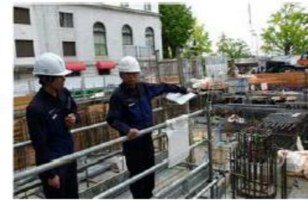
配筋作業の状況及び昇降設備の確認を行う 横浜南署署長ほか
